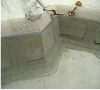
Abdichtung der Fugen
