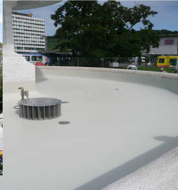
Mit FRANKEN-Systems abgedichtetes Brunnenbecken
